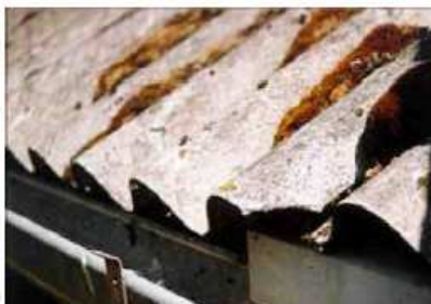
Pokrycie z płyt falistych azbestowo - cementowych
