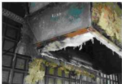
Płótno azbestowe w przewodach wentylacyjnych
