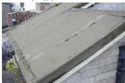
Azbestowa pilśń dachowa
