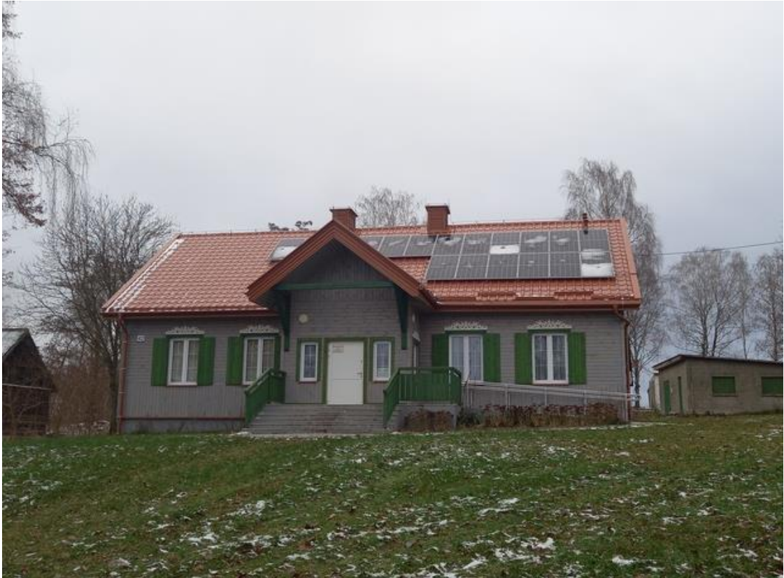
Świetlica wiejska w Wiejkach
