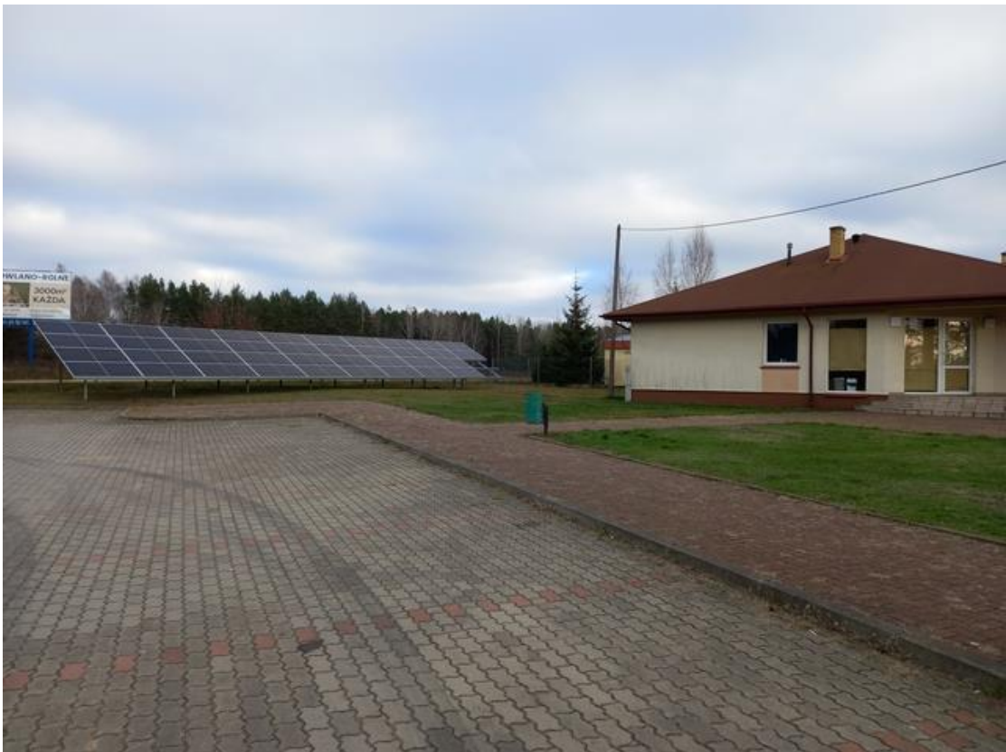
Budynek socjalny przy boisku sportowym w Zarzeczanach
